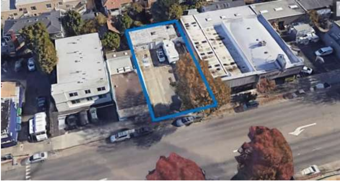
Looking southeast across San Pablo Av
